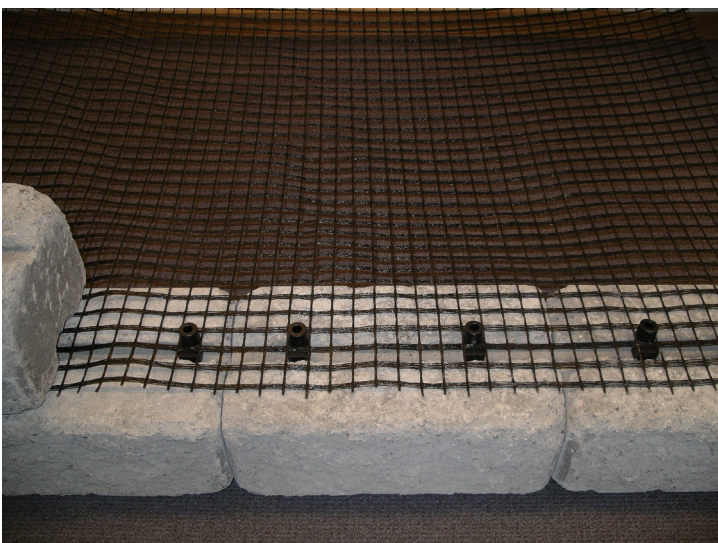
Mynd 4. Jarðvegsnet á fyrsta steinum. Setjið netið yfir plastlásana. Látið lásana koma upp úr þriðju möskvarðinni í netinu þannig að netið sé sem næst brún steinanna án þess þó að sjást. Þannig nær netið bestri festu.
